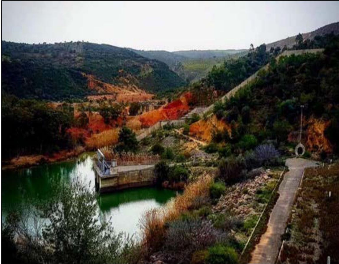
Barrage Sidi Salem
